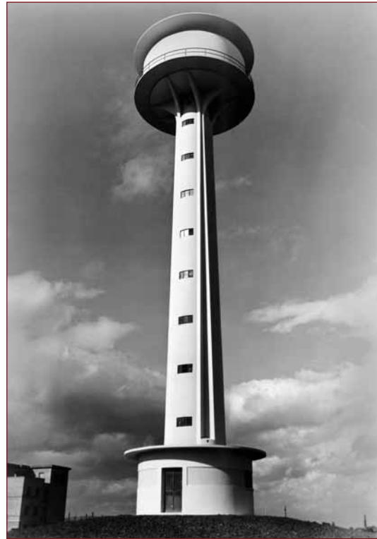
Complesso sanatoriale IX Maggio di Vecchiazzano, 1940 Torre dell'acqua, Forlì
