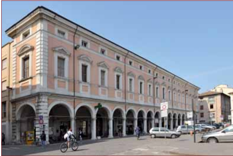
Palazzo Congregazione Carità - OIR Cesena - Direzione AUSL - Cesena
