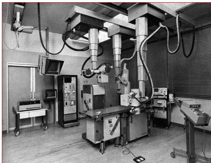
Particolare della sala Emodinamica e Angiocardigrafia in corso di completamento
